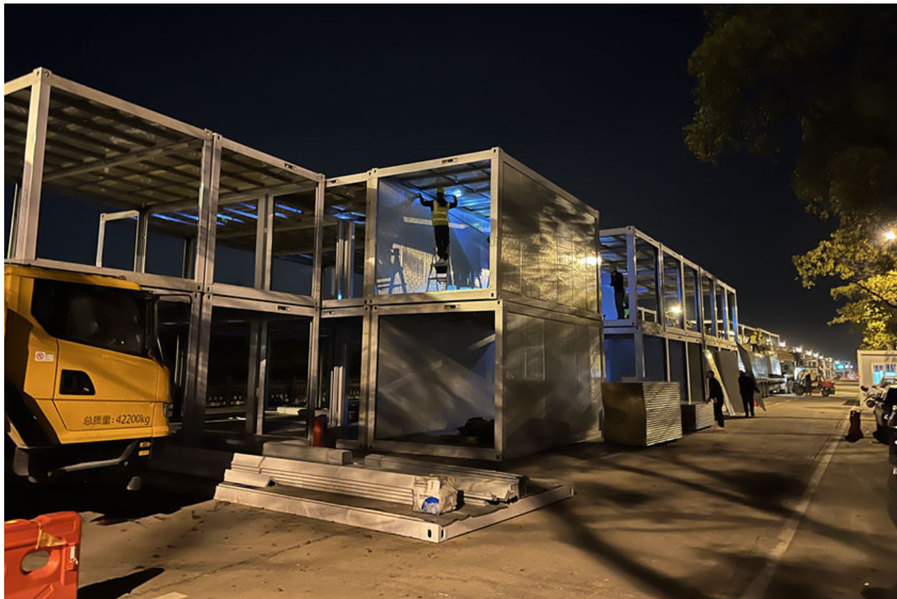
东海老年护理医院附近正在建造中的集中隔离收治点。图：受访者提供
